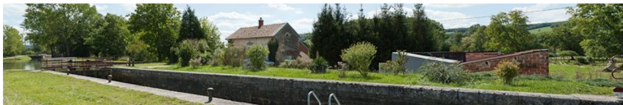
Vue d'ensemble du site d'écluse.
