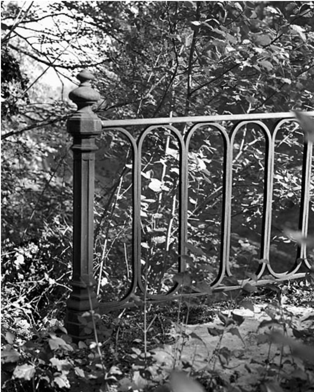
Garde-corps : détail d'un potelet.
