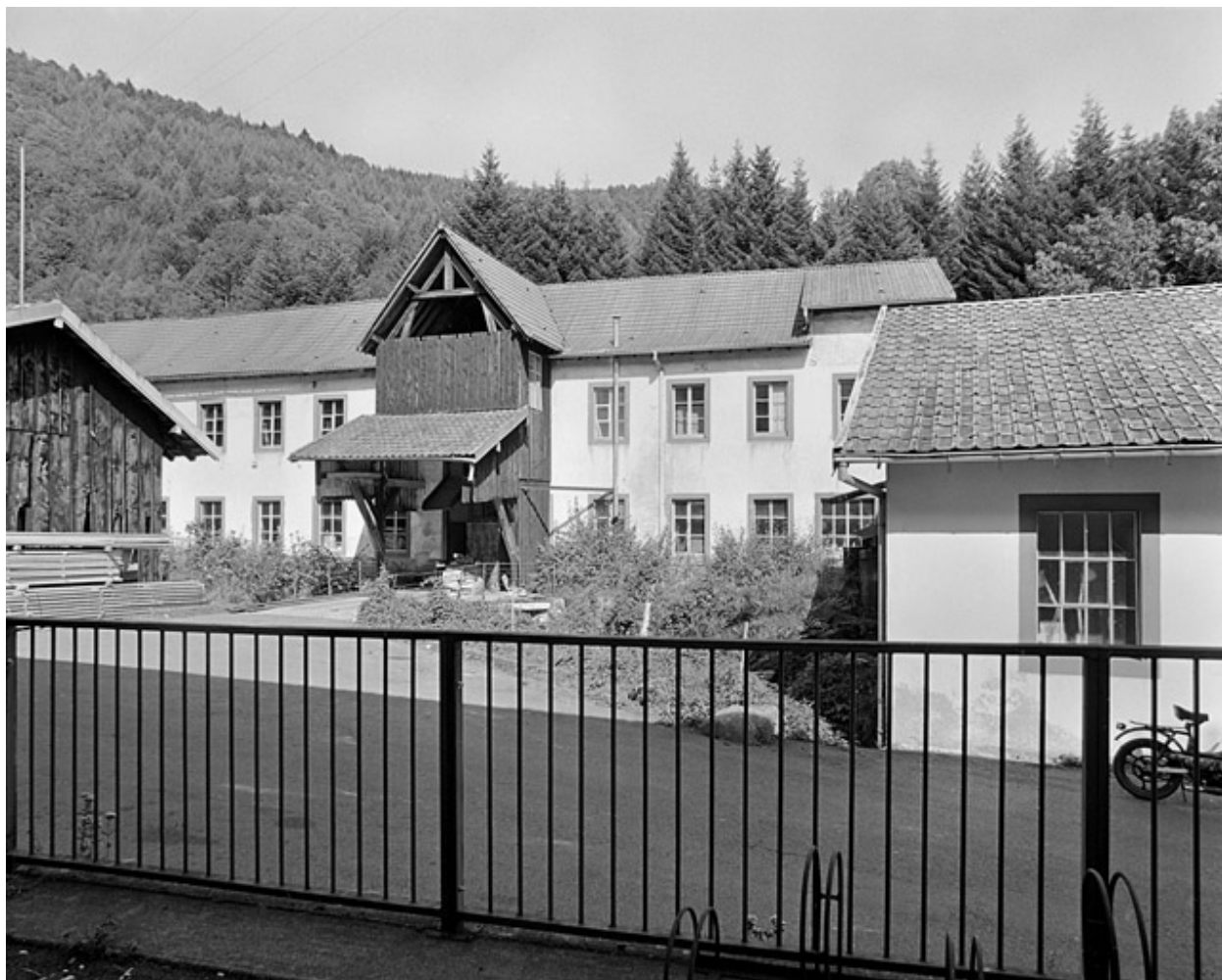
Atelier de fabrication (préparation, bobinage, ourdissage, etc).
