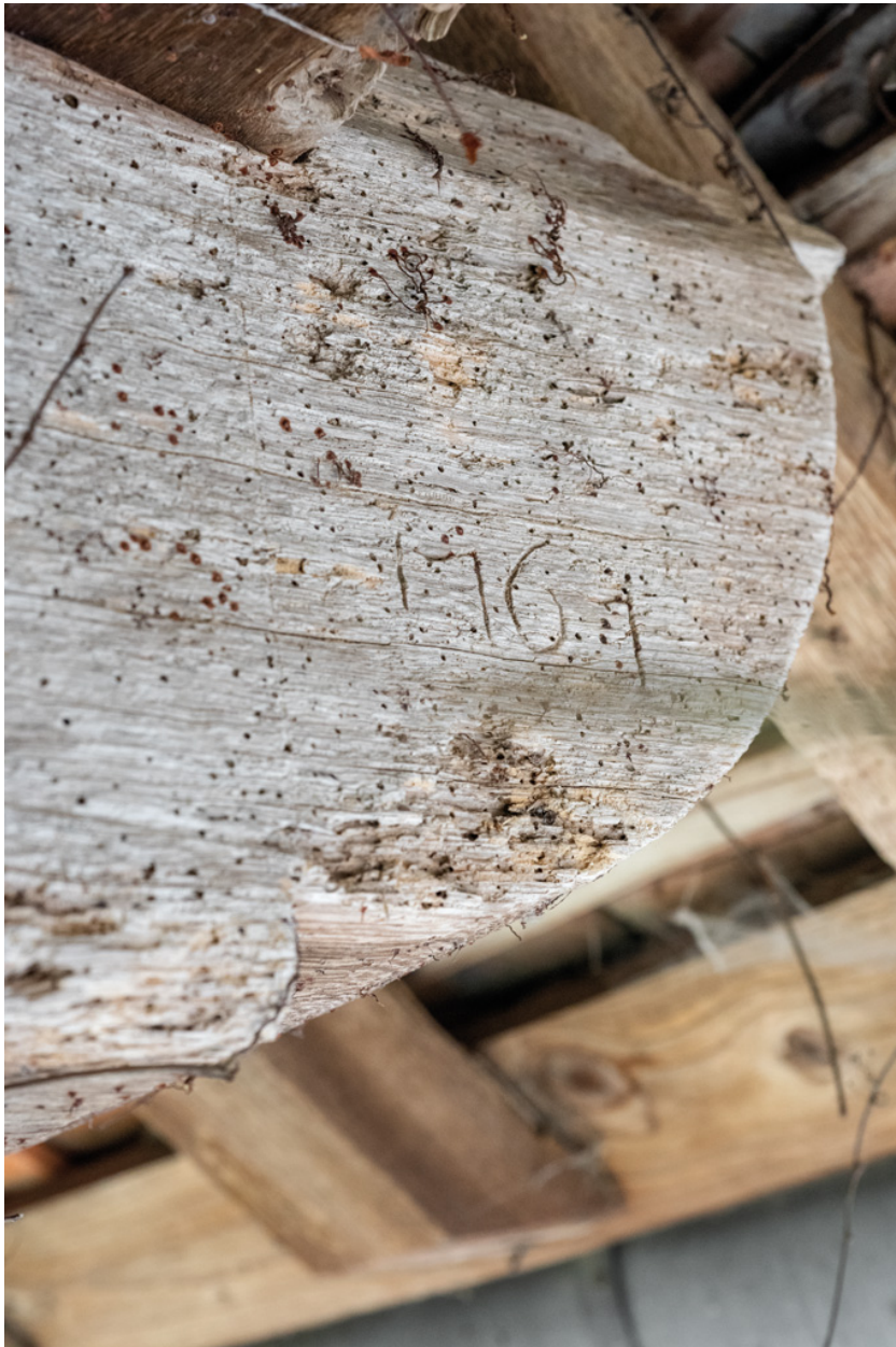
Bâtiment agricole nord. Date gravée sur un entrain de la charpente.
