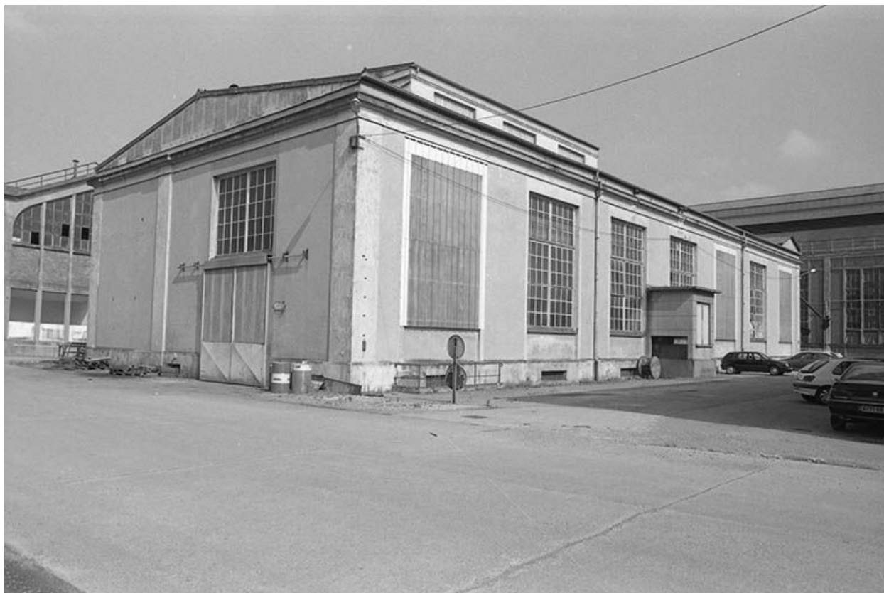
Sous-station électrique, vue de l'ouest.
