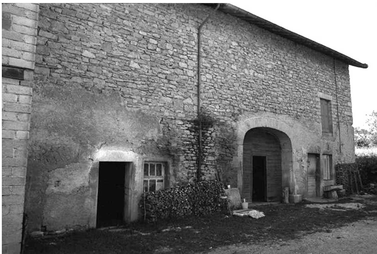
Ferme cadastrée 1957 A1 232 : façade antérieure.
