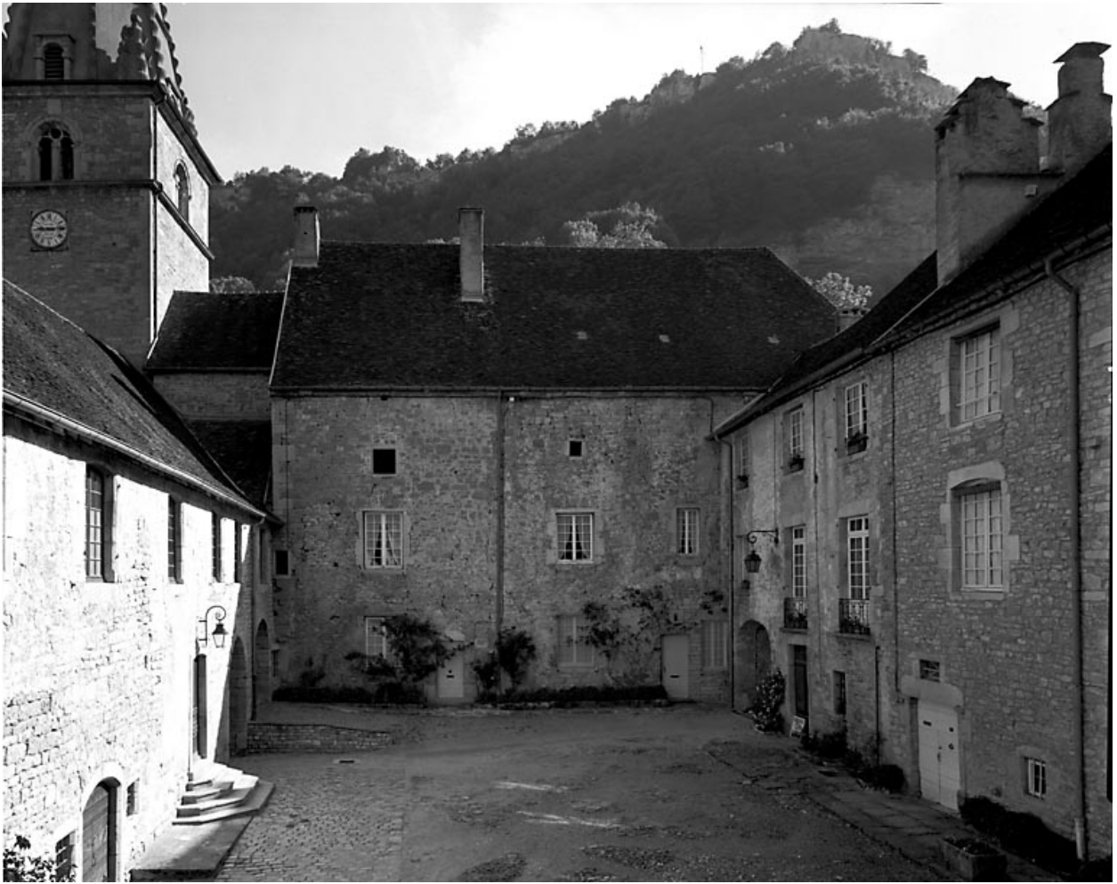
Bâtiment au sud du chœur de l'église abbatiale, façade sur la cour des chanoines.
