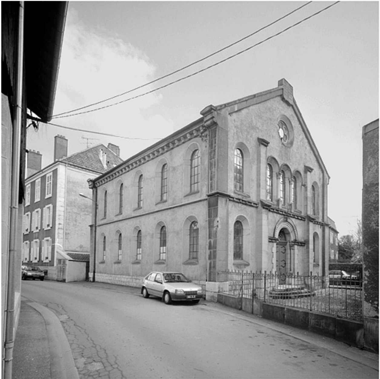
Vue d'ensemble côté rue de la Synagogue.
