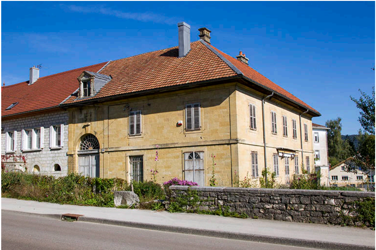
Corps sud : vue d'ensemble, depuis le sud-ouest.
