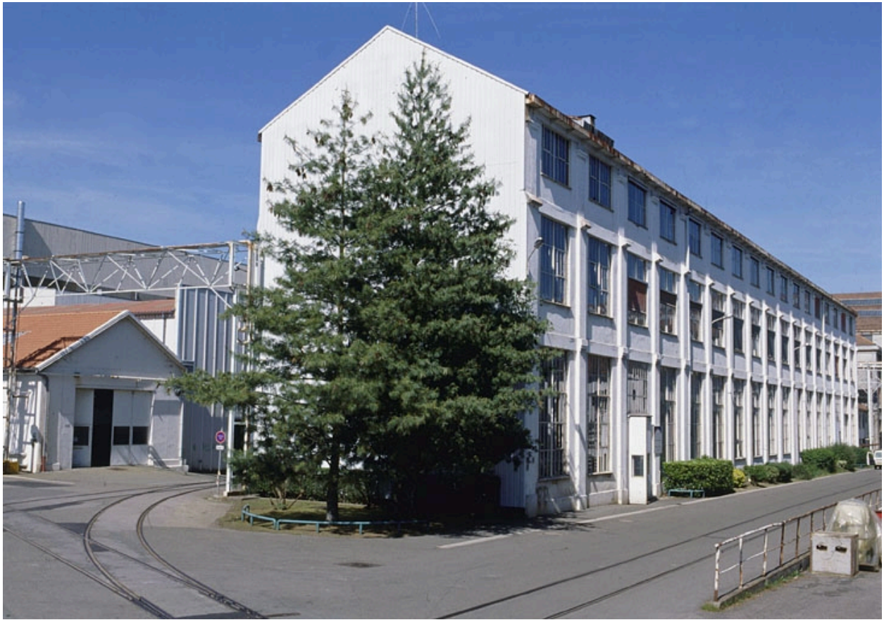
Anciens bureaux des contrôleurs.
