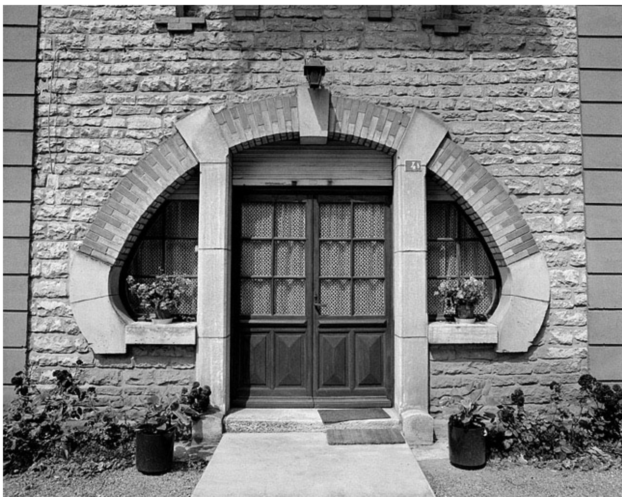
Détail de la porte d'entrée de l'habitation.
