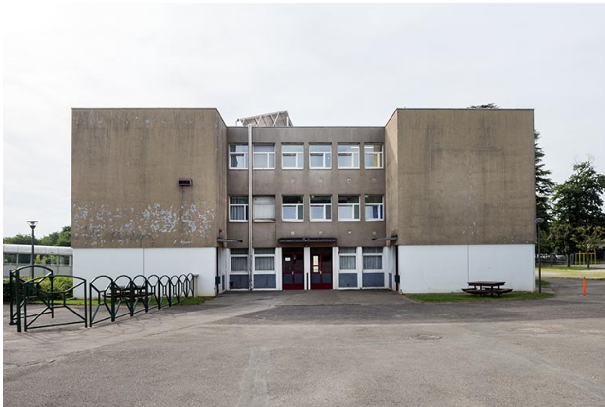
Entrée du bâtiment d'internat et restauration.
