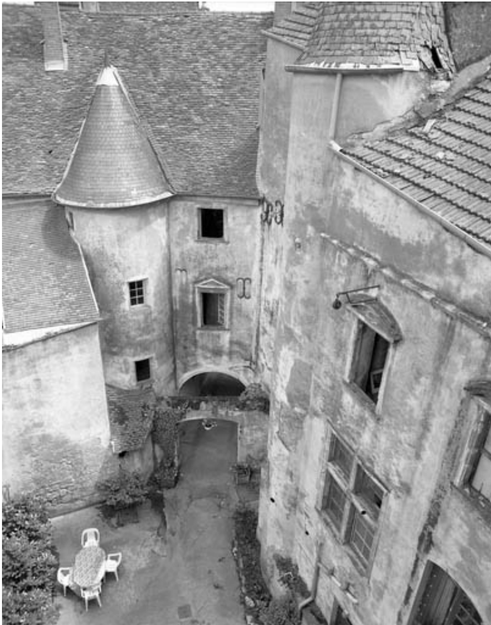
Bâtiment droit : vue plongeante depuis la cellule de saint Pierre Fourier.
