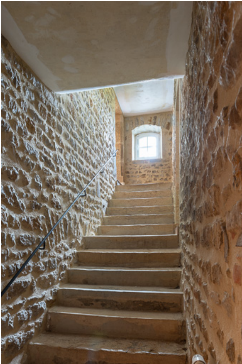
Escalier de la maison en pierre de taille
