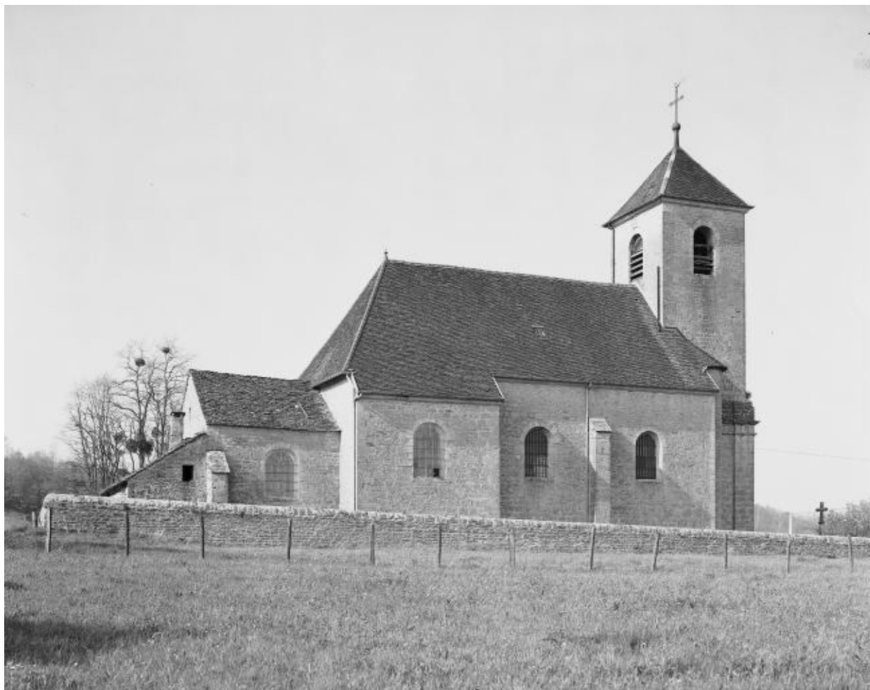
Façade latérale gauche.
