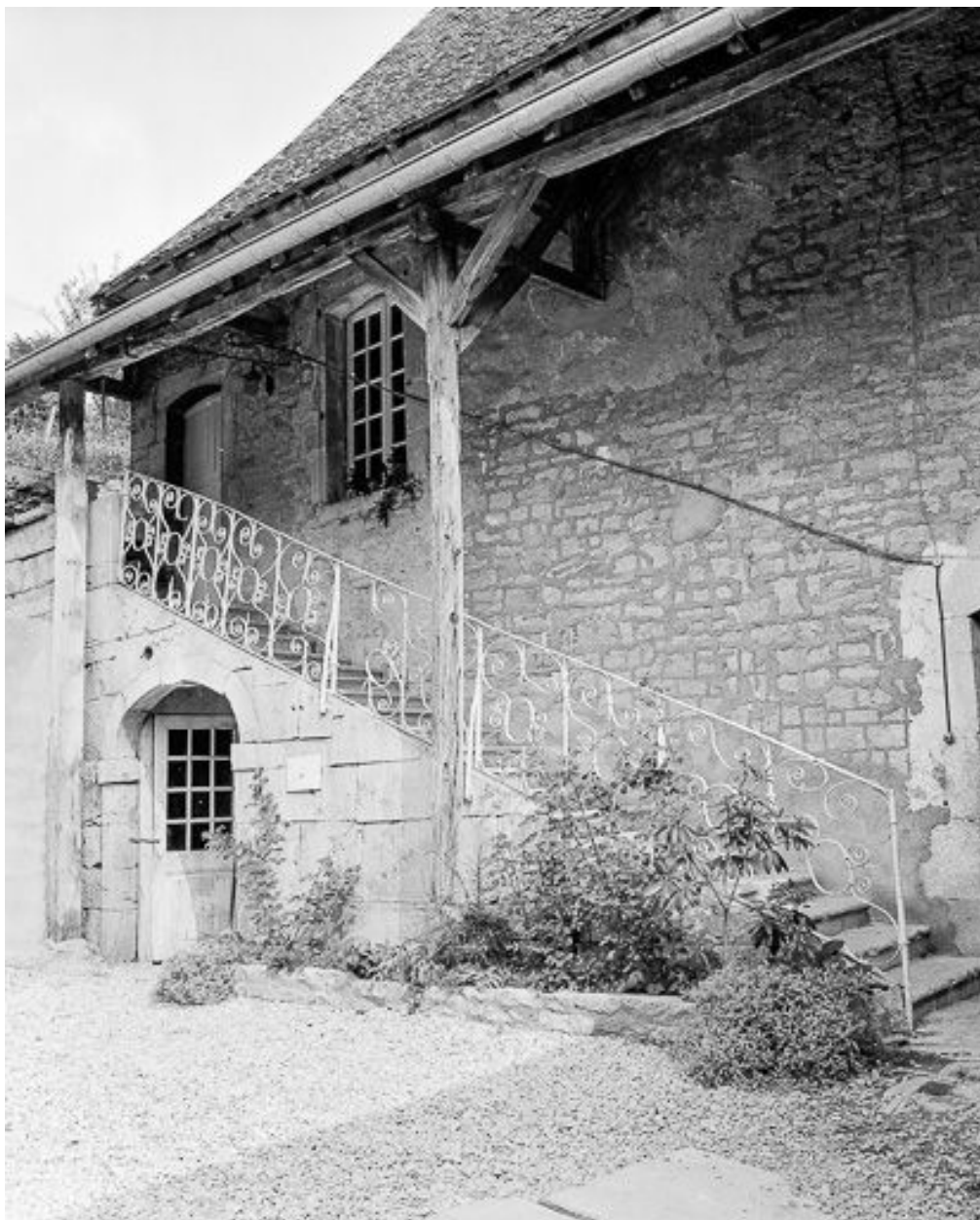
Détail de l'escalier extérieur de l'habitation.
