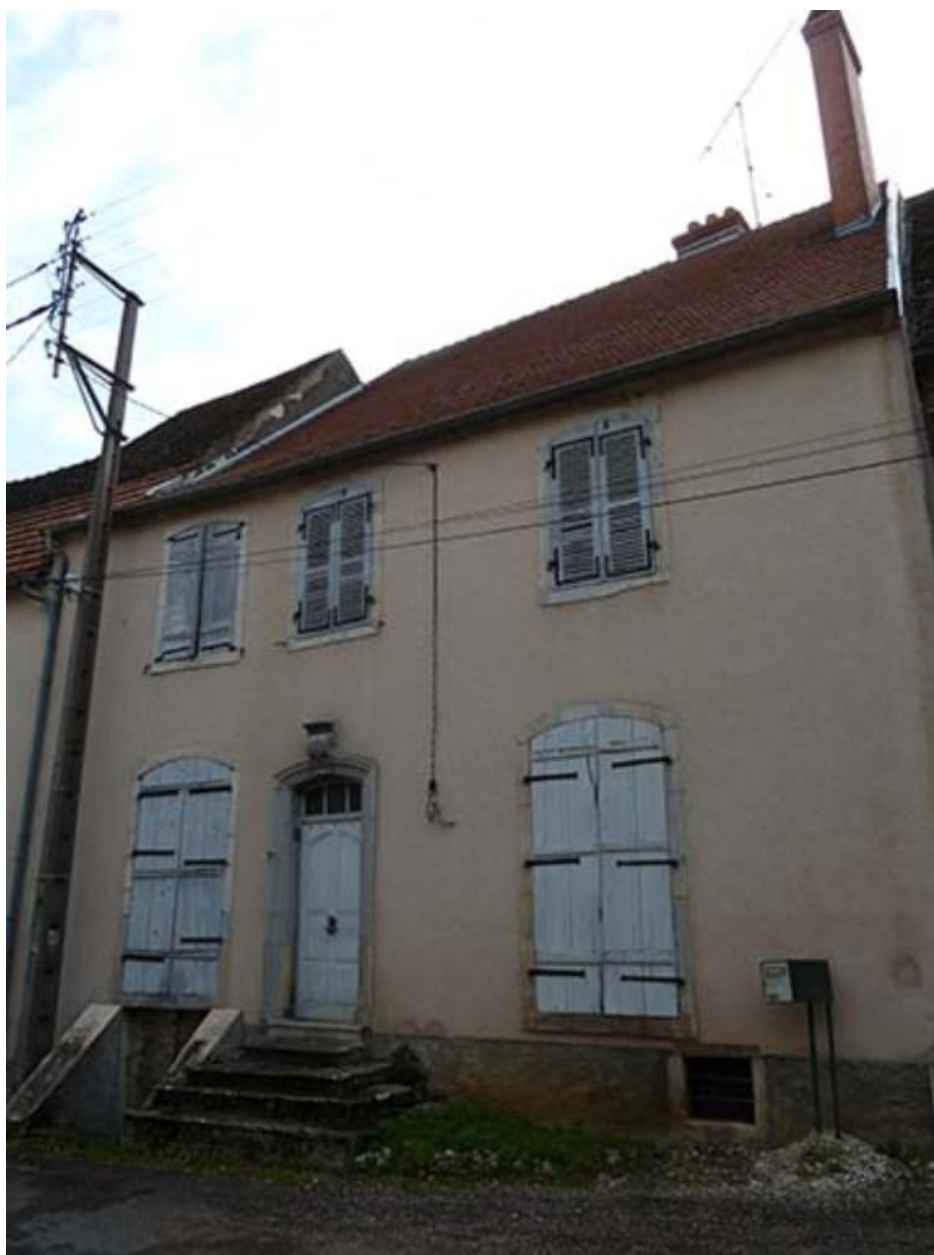
Vue générale nord-ouest
