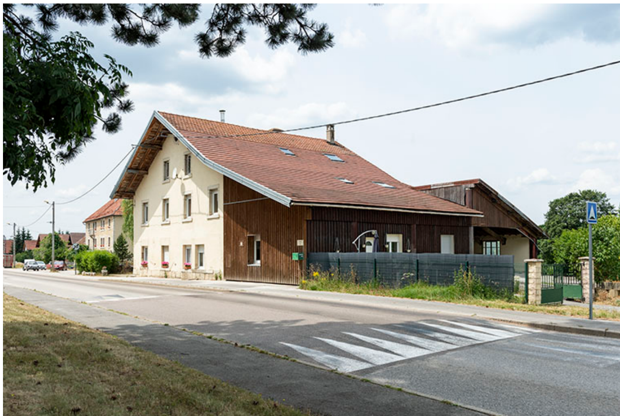
Façades antérieure et latérale droite.
