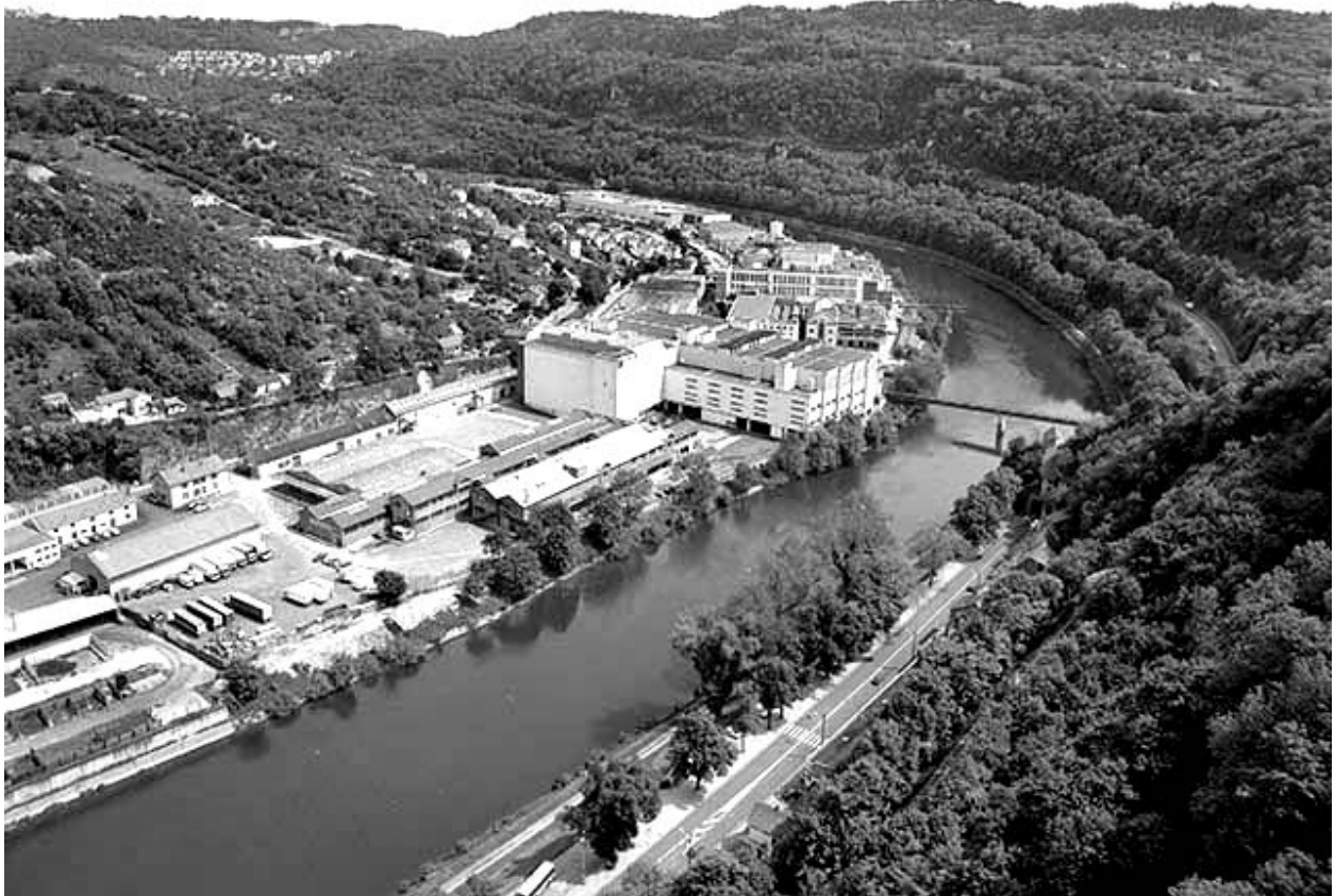
Vue d'ensemble de l'usine B depuis l'ouest : extrémité sud.
