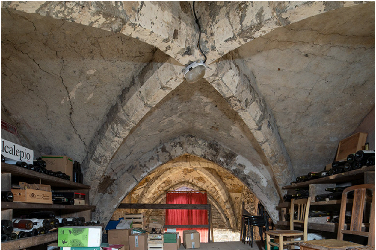
Cave du bâtiment sur rue. Croisée d'ogives ouest de la travée centrale.
