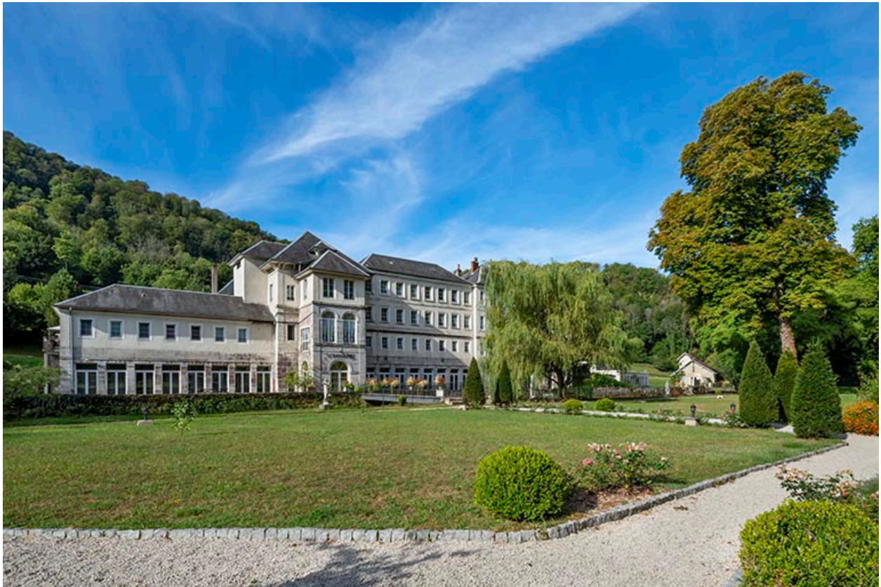
Façade principale, vue de trois quarts.
