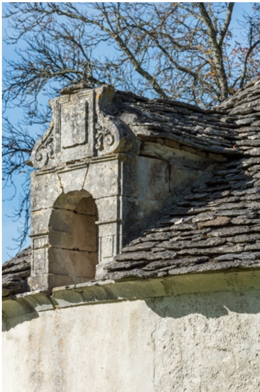
Détail de la lucarne sud.
