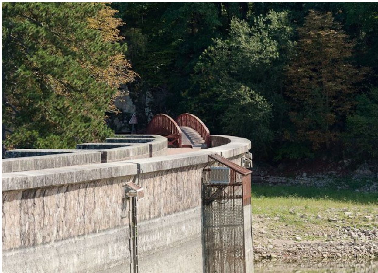
Vue de la digue du réservoir.
