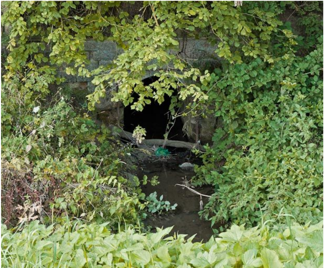
Vue de l'aqueduc.
