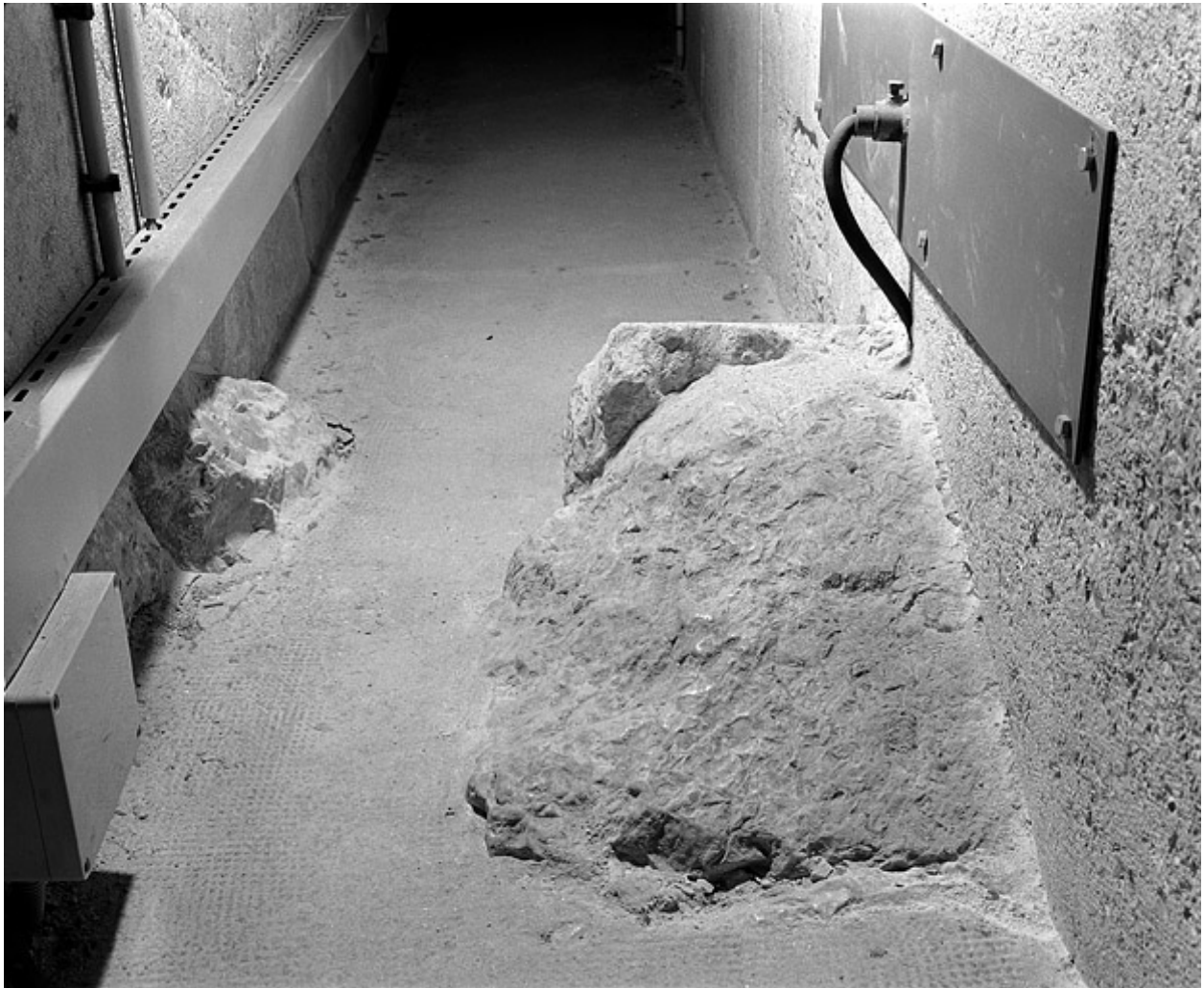
Intrados d'une grande arcade dans la coursière haute.
