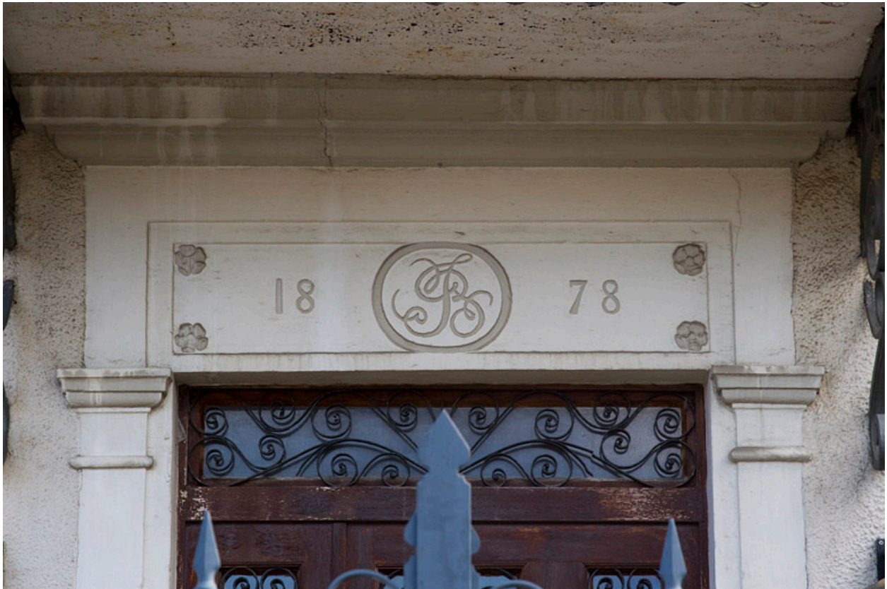
Logement patronal : linteau de la porte d'entrée.
