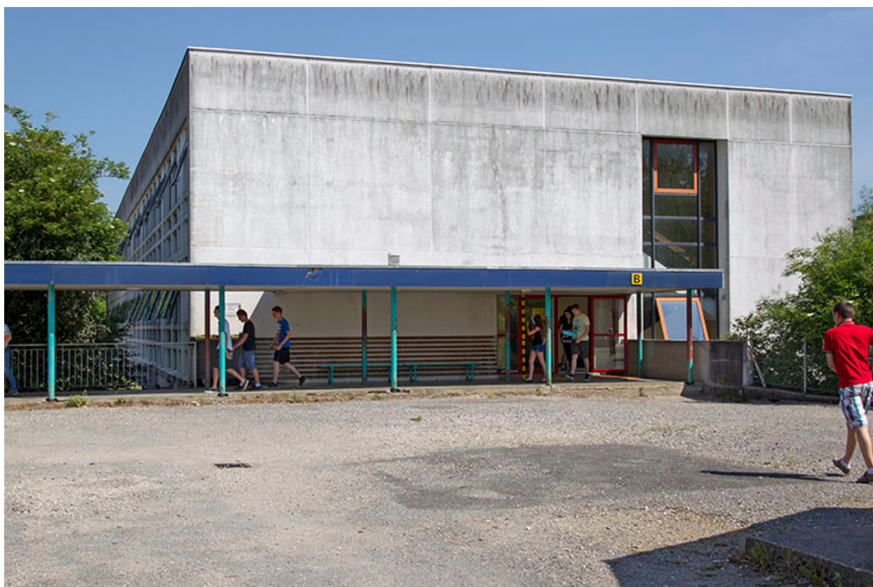
Pignon sud de l'externat.
