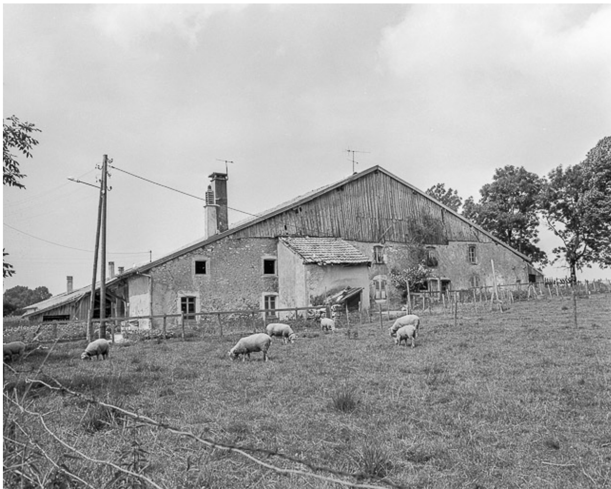
Pignon d'habitation et goutterot.
