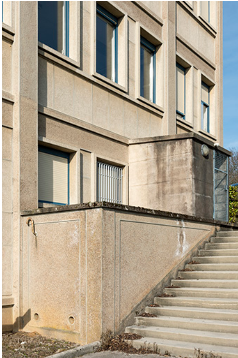
Façade latérale gauche (corps oriental) : escalier indépendant.
