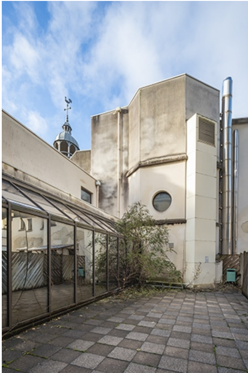
Cour, ancienne tour du réservoir et aile de la piscine (à gauche).
