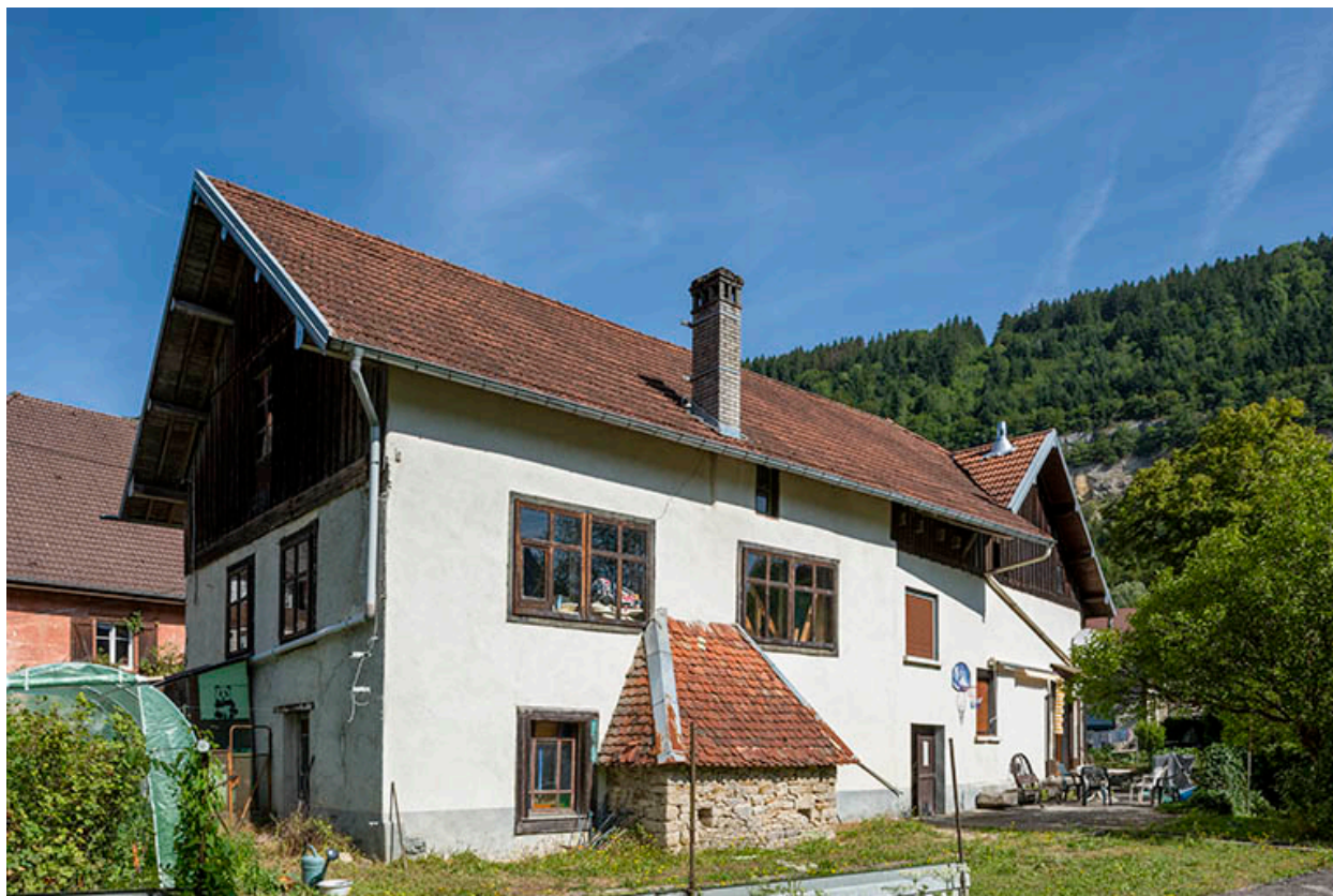
Forge : façades sud et est.
