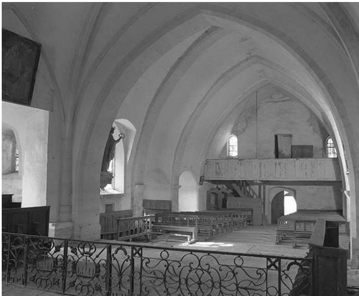
Intérieur : élévation droite vue depuis le chœur.
