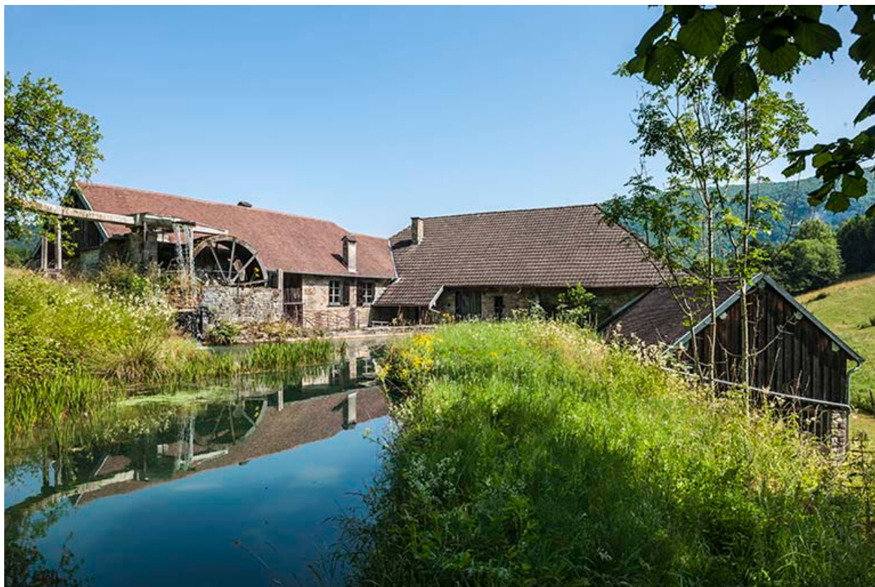
La taillanderie vue depuis le canal d'amenée.
