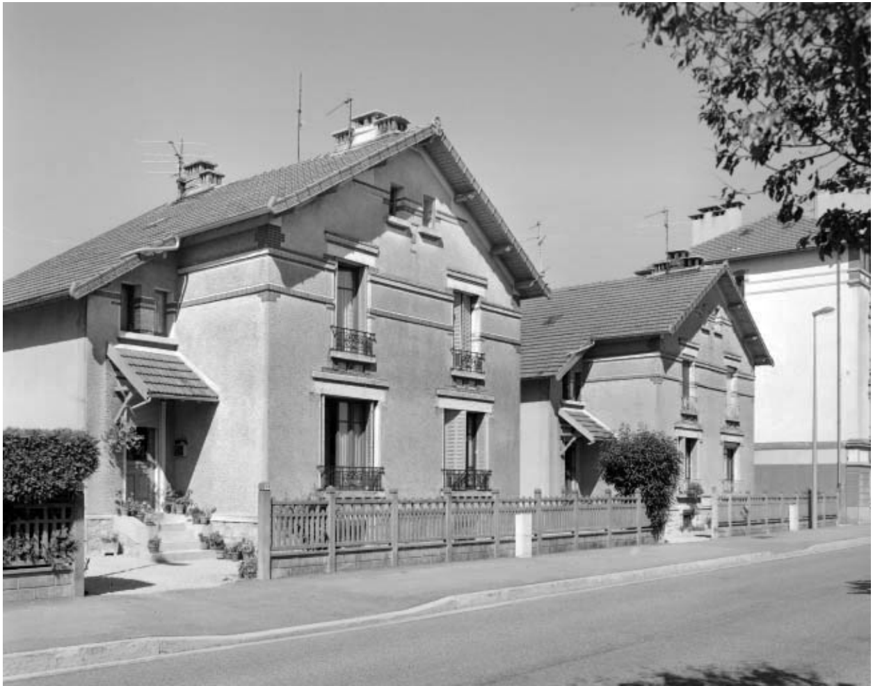
Logements doubles vus de trois quarts.
