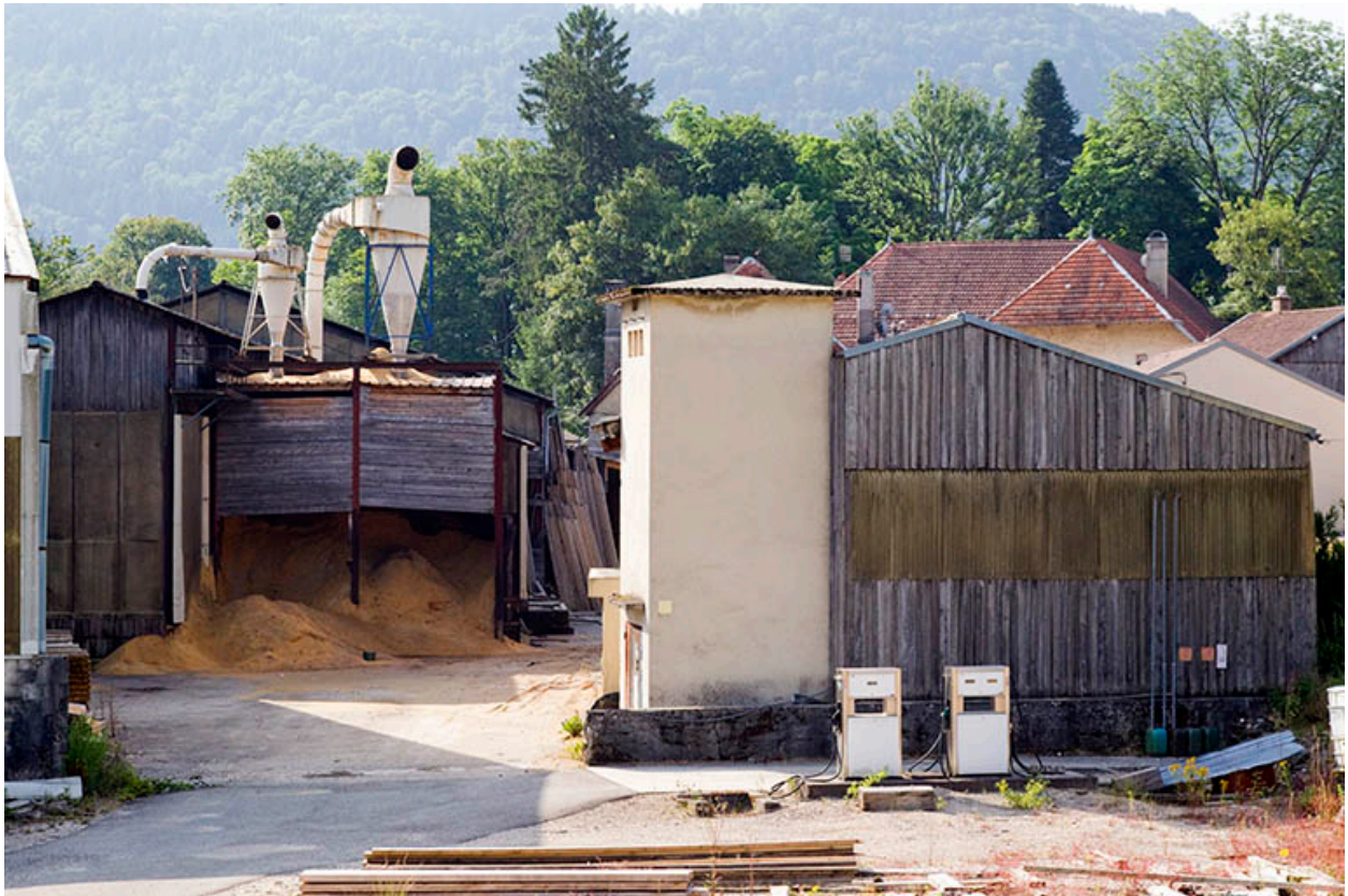
Silos à sciure et magasin industriel situés à l'ouest.
