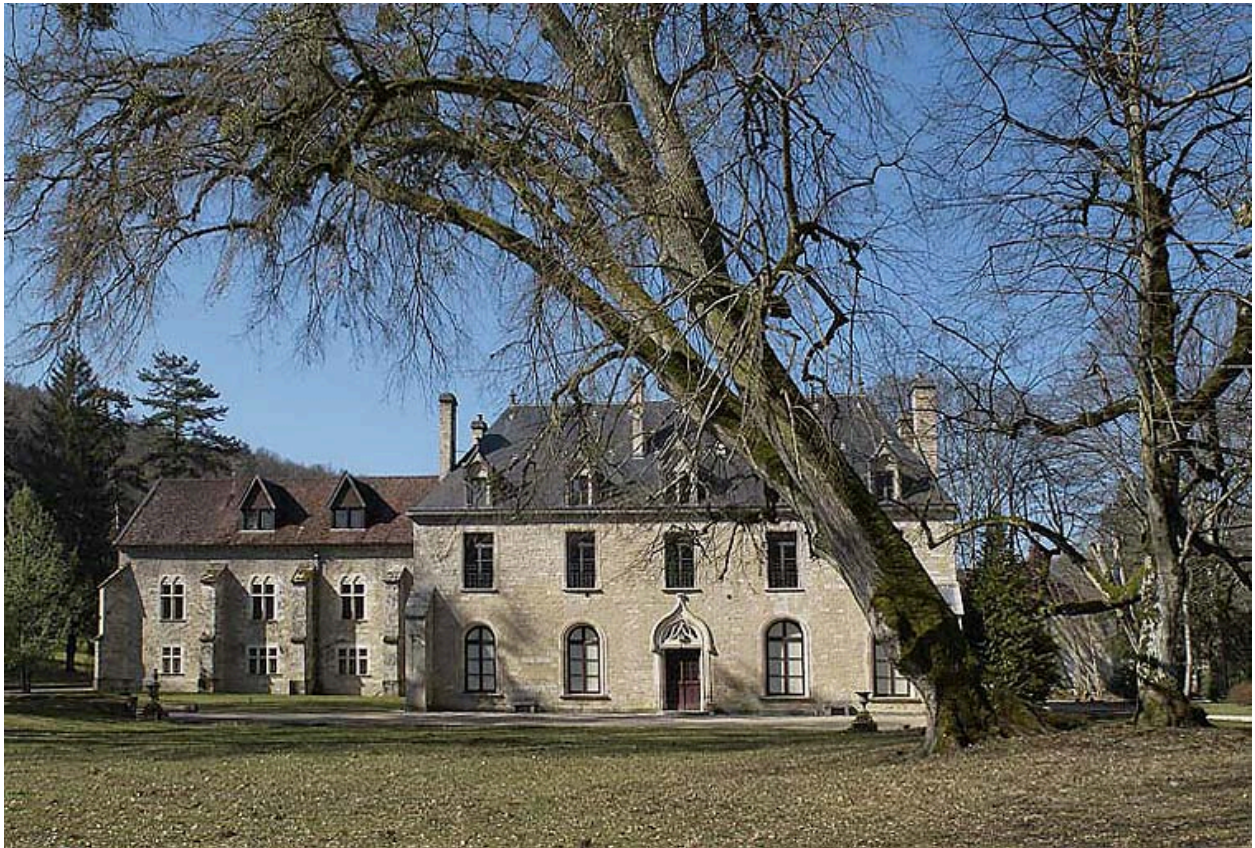
Bâtiment du réfectoire (à gauche) et partie sud de l'aile orientale, vus de l'est.
