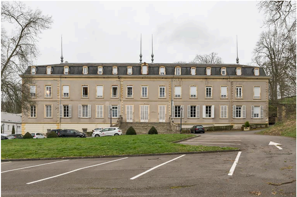
Aile nord, façade.
