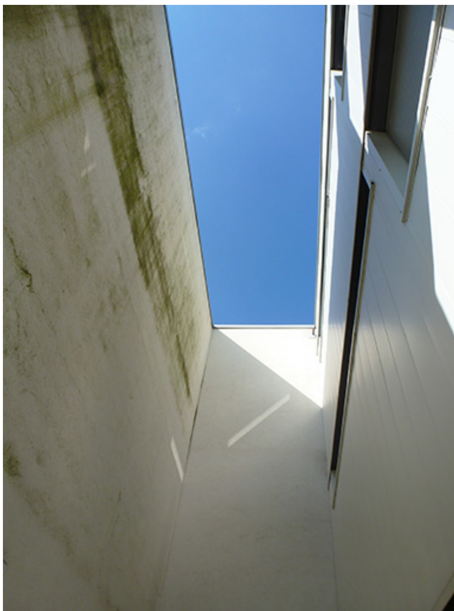
Détail architectural à la jonction des externats.
