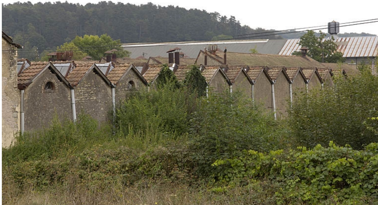
Murs-pignons sud de la salle de tissage.
