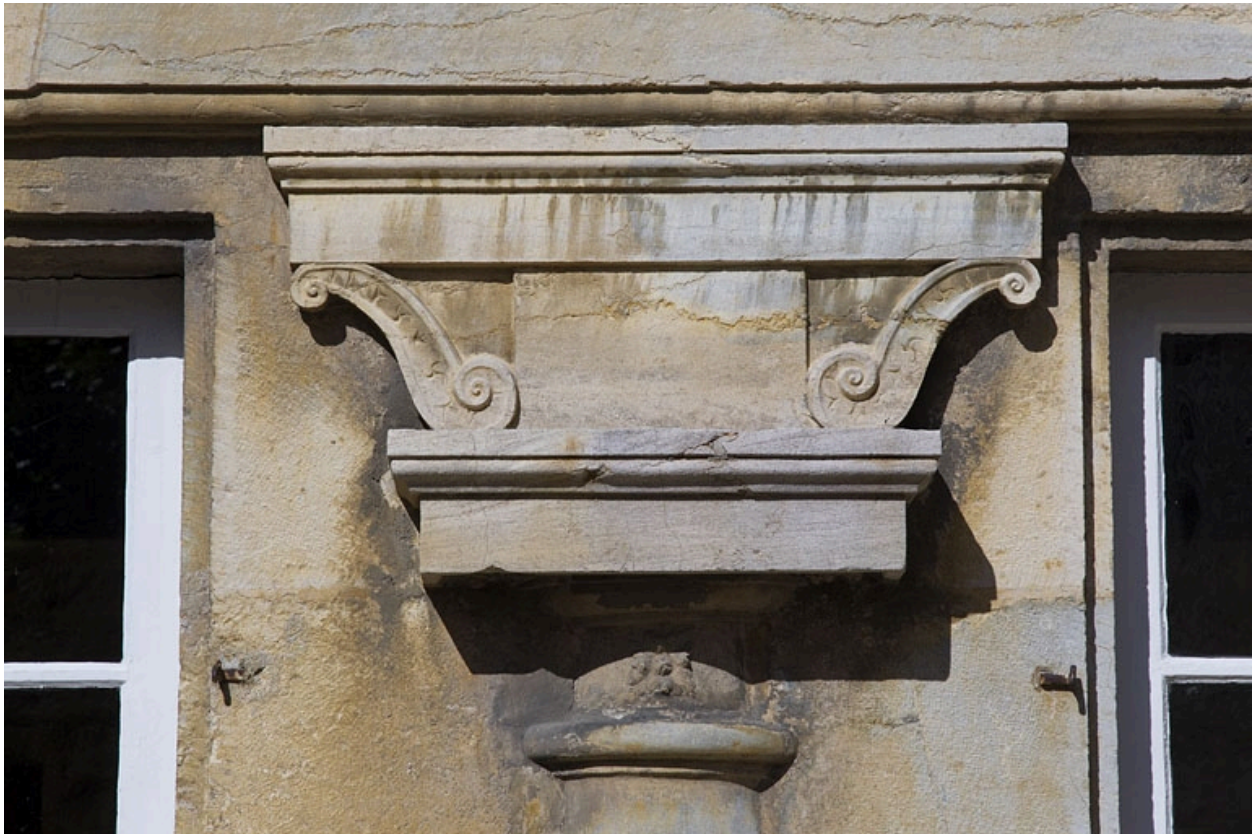
Logis principal, façade postérieure : détail d'une zapata du portique : de face.
