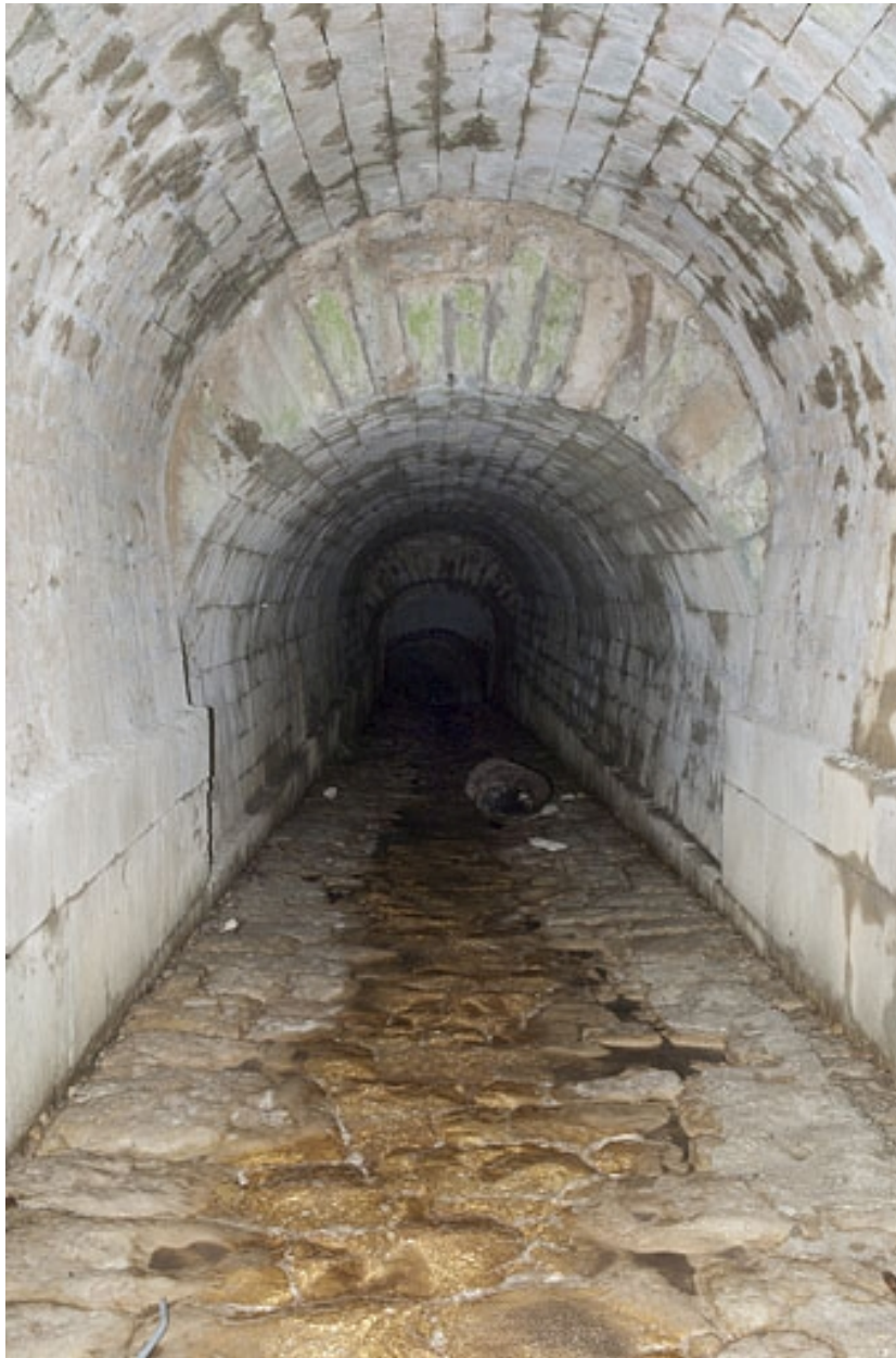
Détail de la voûte du pont-aqueduc du Vaubillon (n° 6).
