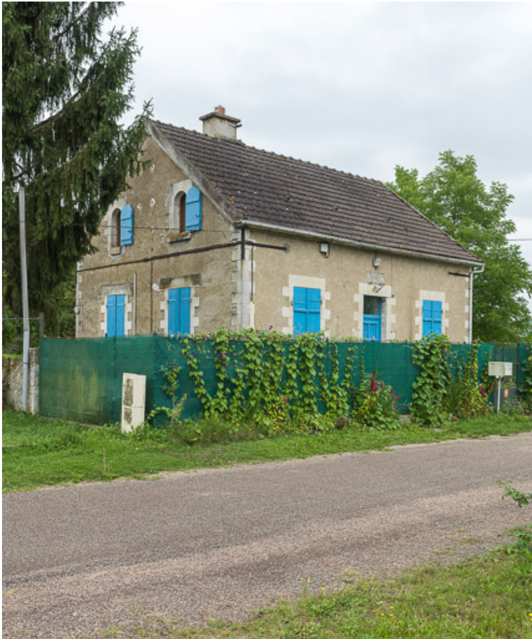
Vue de la maison éclusière.
