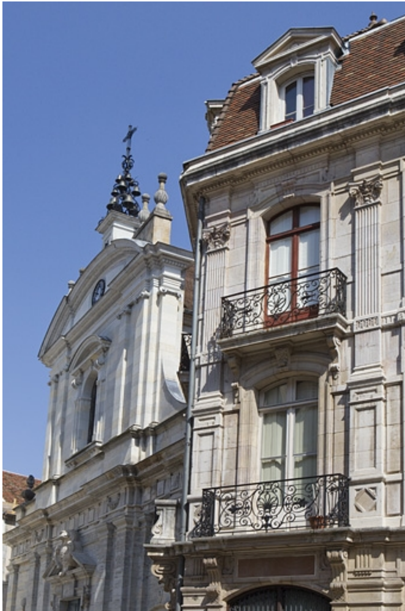
Détail de de deux balcons à gauche de la façade antérieure.
