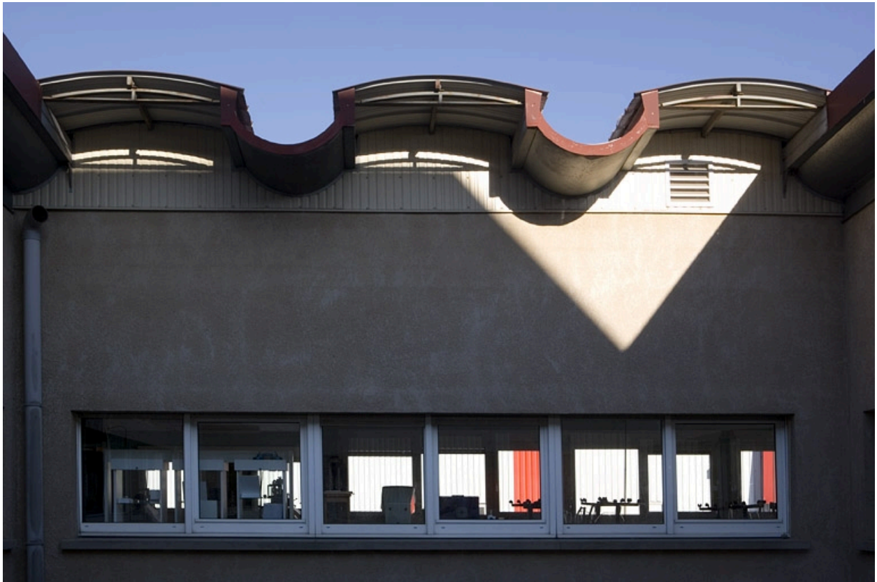
Site récent, atelier d'horlogerie : toiture.
