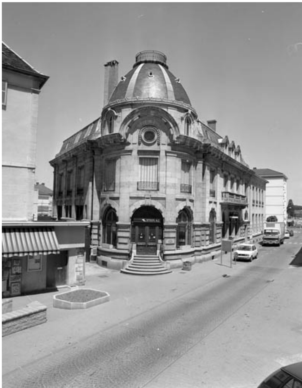
Vue d'ensemble éloignée.
