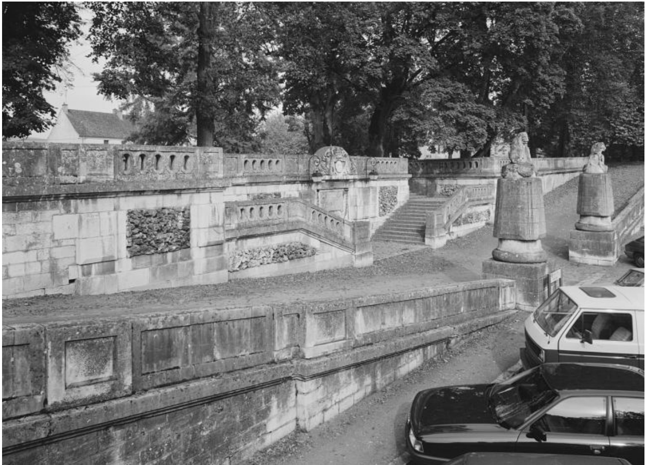
Vue d'ensemble, de côté, depuis la rampe d'accès (1988).
