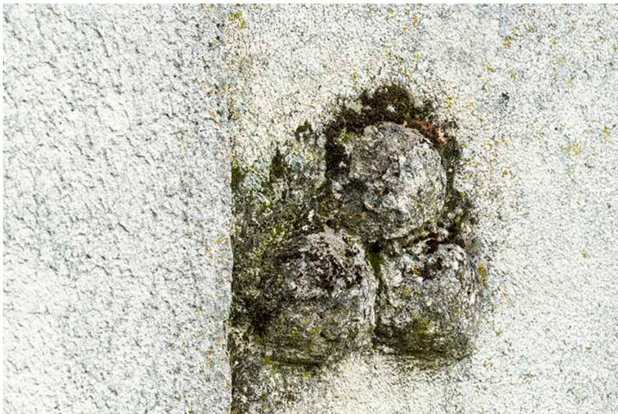
Bâtiment de 1723, façade latérale gauche : boules apotropaïques.
