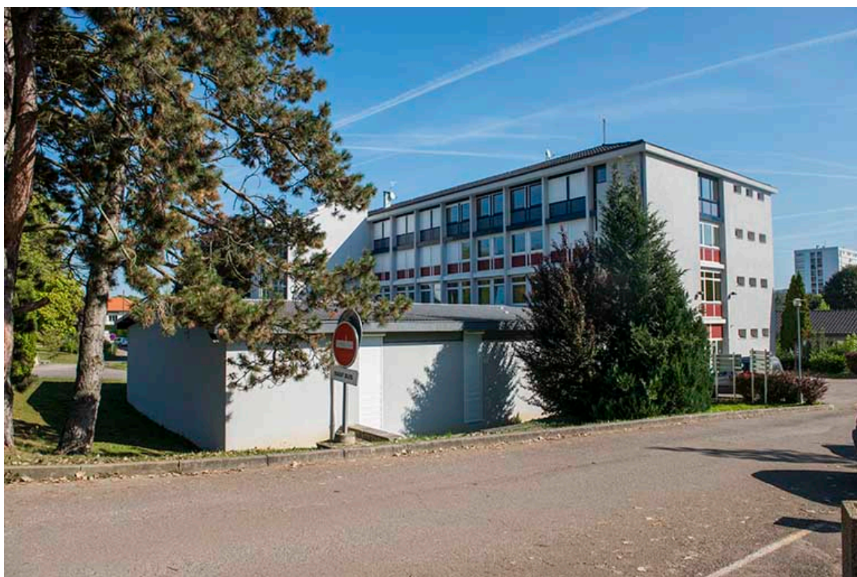
Façade sud de l'amphithéâtre.
