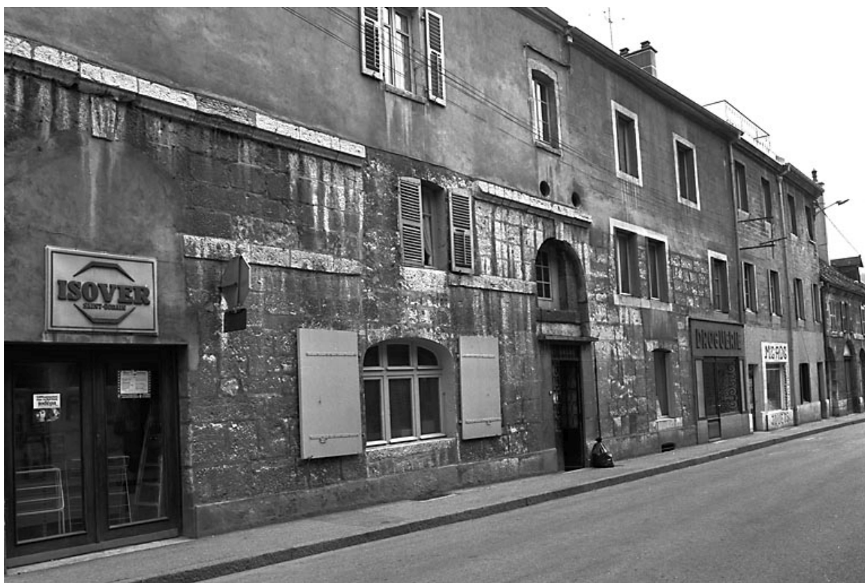
Façade sur la rue Montrieux.
