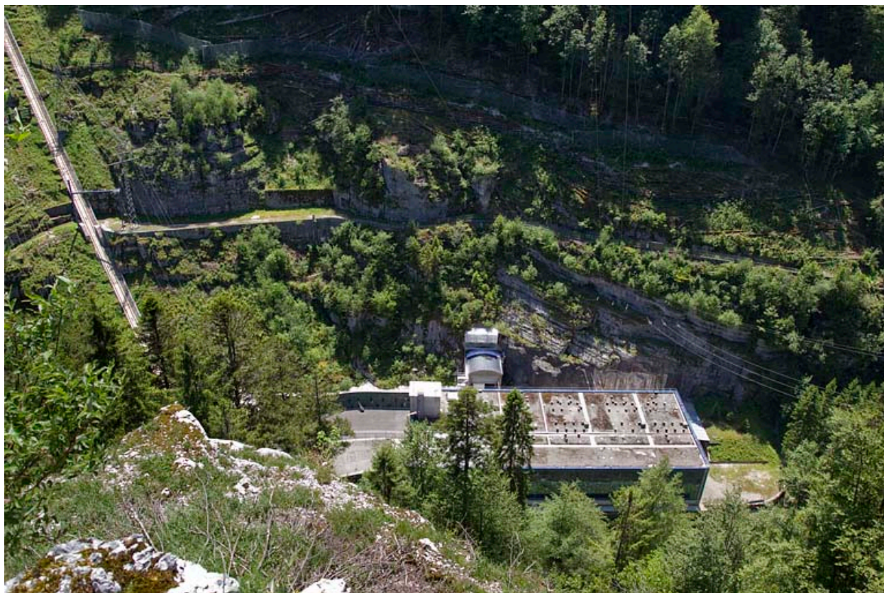
Centrale du Châtelot : vue plongeante sur le funiculaire et la centrale.
